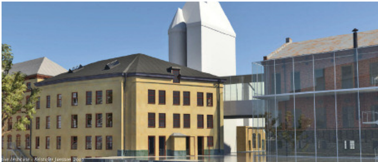
Kopparhammaren 7: Under 2010 och inledningen av 2011 kommer drygt 70 mkr att investeras för bl a Norrköpings kommuns biograf Cinema i fastigheten Kopparhammaren 7 i Norrköping.
